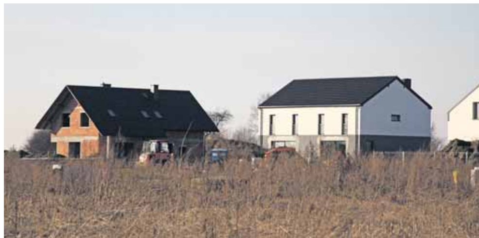
Nowe domy powstają na osiedlu Sielanka
